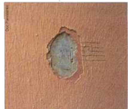
Un véritable millefeuille de couches superposées recouvrait certaines parties de la façade.
