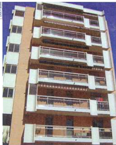
Après ravalement, l'un des immeubles revenu à son état d'origine.
