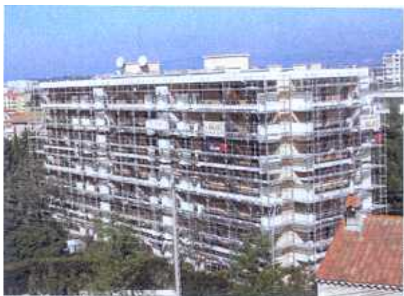
La totalité des façades a été traitée pour chacun des dix bâtiments de la résidence.
