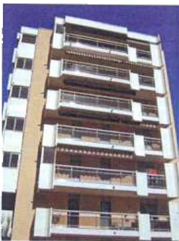
Un des bâtiments déjà ravalé, revêtu à son état d'origine.
